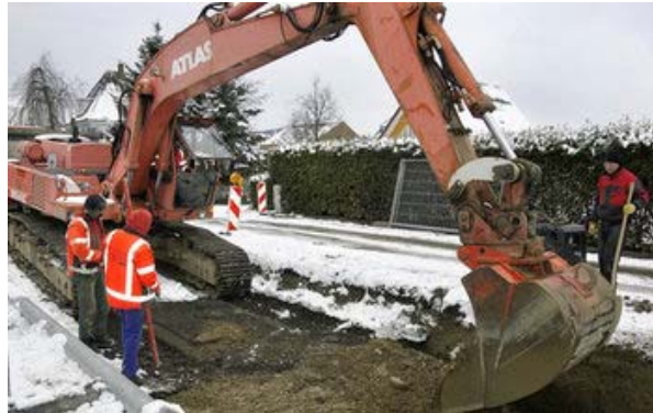
Von Westen nach Osten schreitet die Kanalbaustelle in Warmbach voran. | Foto: Ralf Staub
